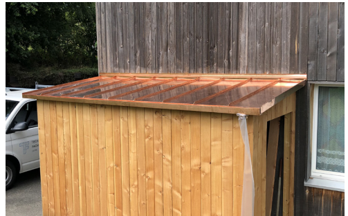
Entlüftungshauben Bekleidung im Doppelfalz
