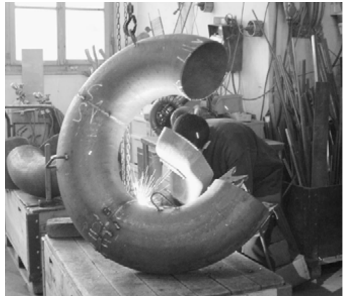
➤ Abbildung 4. Ansetzen der langen Rohrendstücke.
