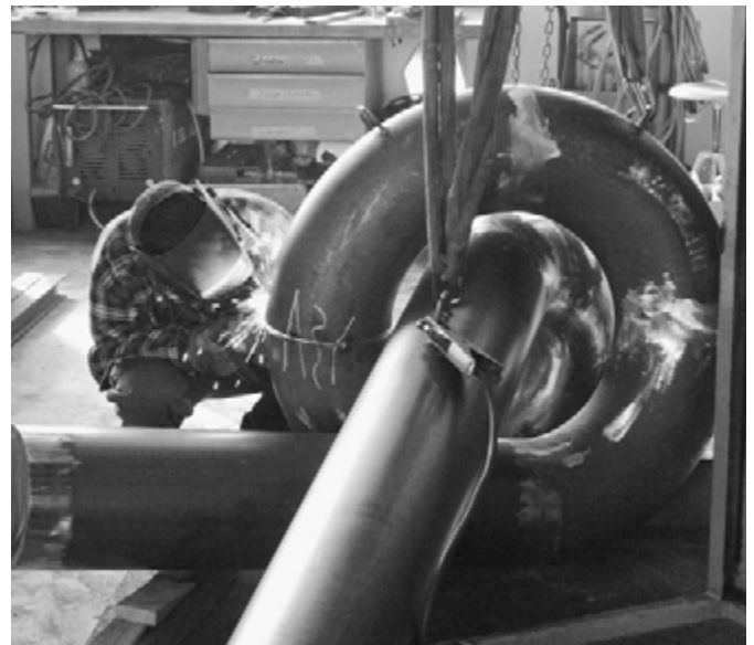
➤ Abbildung 5. Ansetzen der langen Rohrendstücke.
