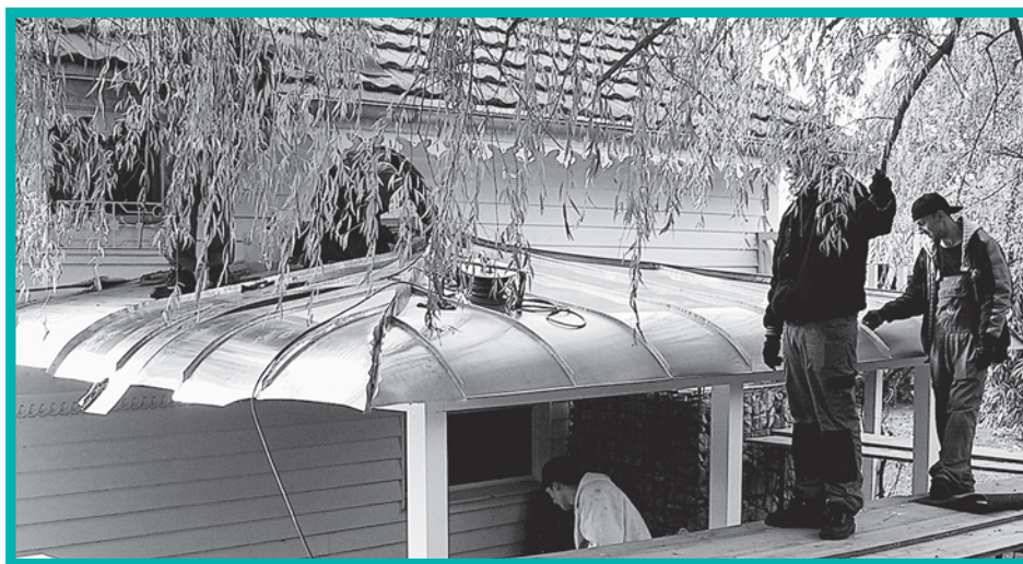
Das neue Dach kurz vor der Fertigstellung.
