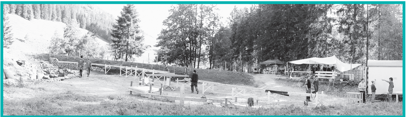
Wasserspielplatz «Gwunderwasser», Tiermatti, Schwenden.
