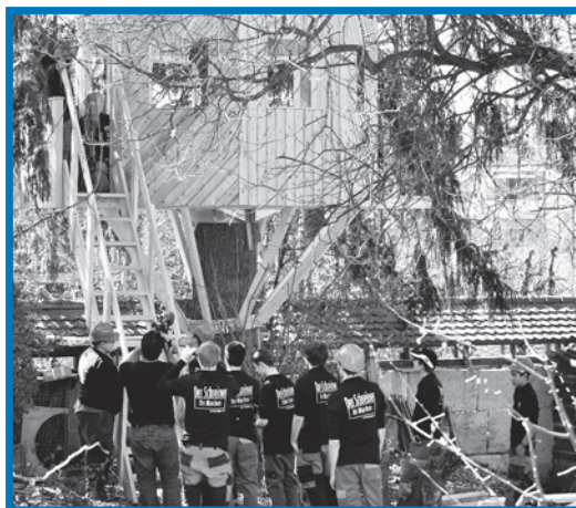
Das fertig montierte Baumhaus.
