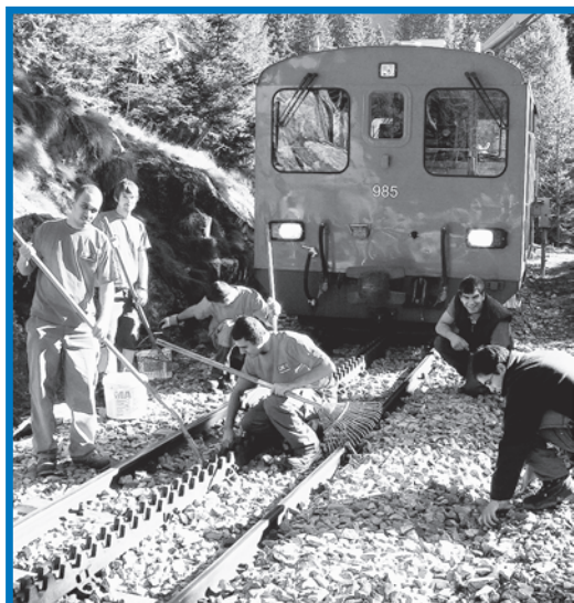
An der Arbeit auf der Walliser Seite, Richtung Oberwald.
