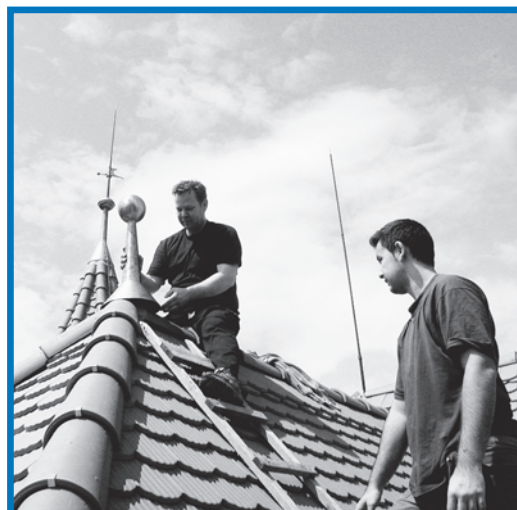
Montage eines Dachspitzes.
