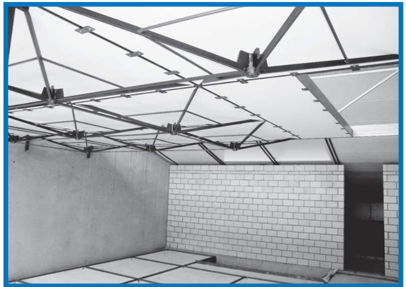
Die montierte Metalldecke.
