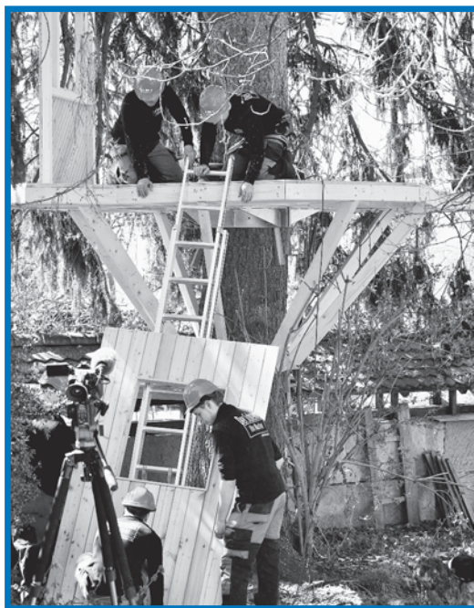
Präzis vorgefertigte Elemente erlauben eine Montage in kürzester Zeit.
