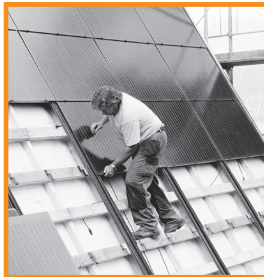
Solarteur® bei der Montage einer Fotovoltaikanlage.
