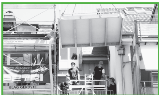
Balkon wird in die enge Nische eingefahren.
