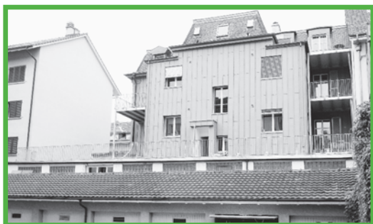
Hausansicht mit den neuen Balkonen (links und rechts) und der neuen Fassade.
