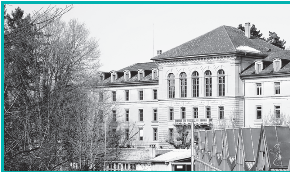
Die Fotovoltaikanlage auf dem Dach des LWB-Hauptgebäudes ist im Kanton Bern bei einem denkmalgeschützten Gebäude eine Premiere.
