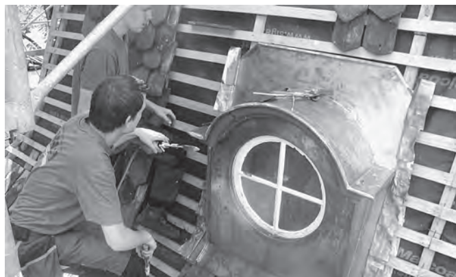
➤ Anfertigung und Montage von zwei Gauben, Schifferliweg Bern.
