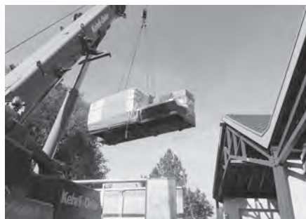
➤ Der Hauptteil der Maschine wird vom Lastwagen geladen.
