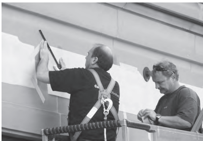
➤ Bei der Montage der neuen Lettern ist Massarbeit gefragt.
