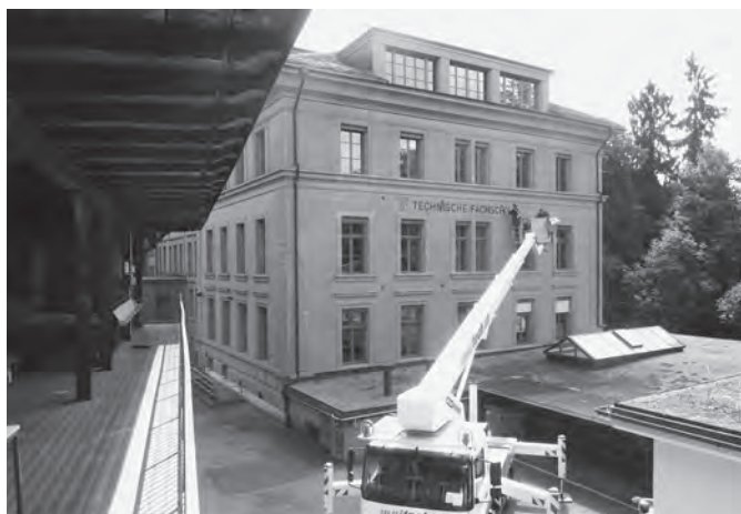
➤ Nach dem Entfernen der «alten» Lettern der Lehrwerkstätten Bern werden die neuen Lettern sorgfältig angebracht.
