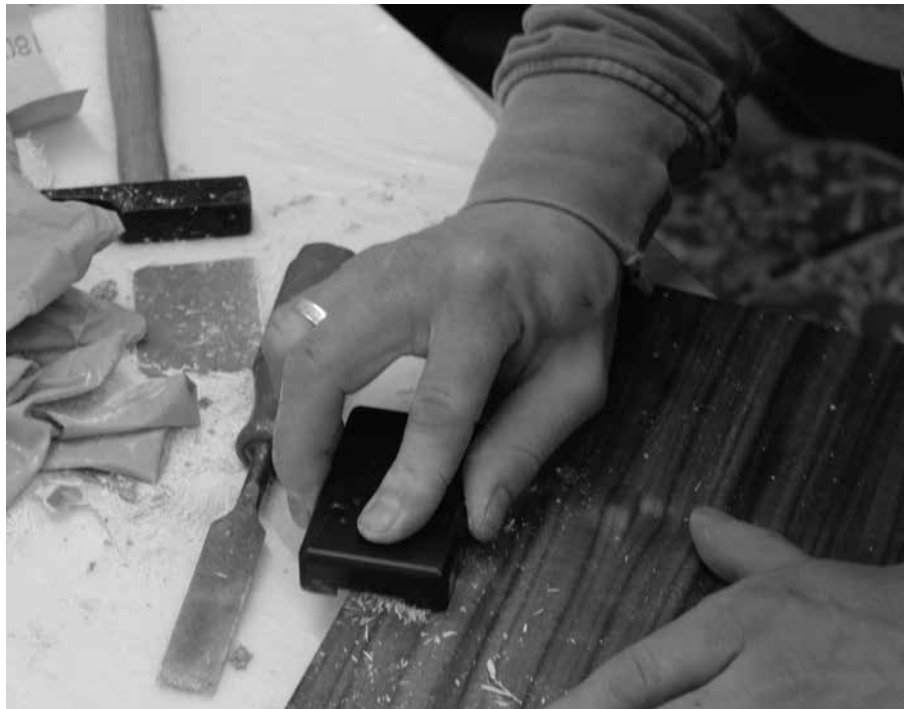
➤ Auf der Baustelle braucht es für Reparaturen an Oberflächen besondere Tricks.
