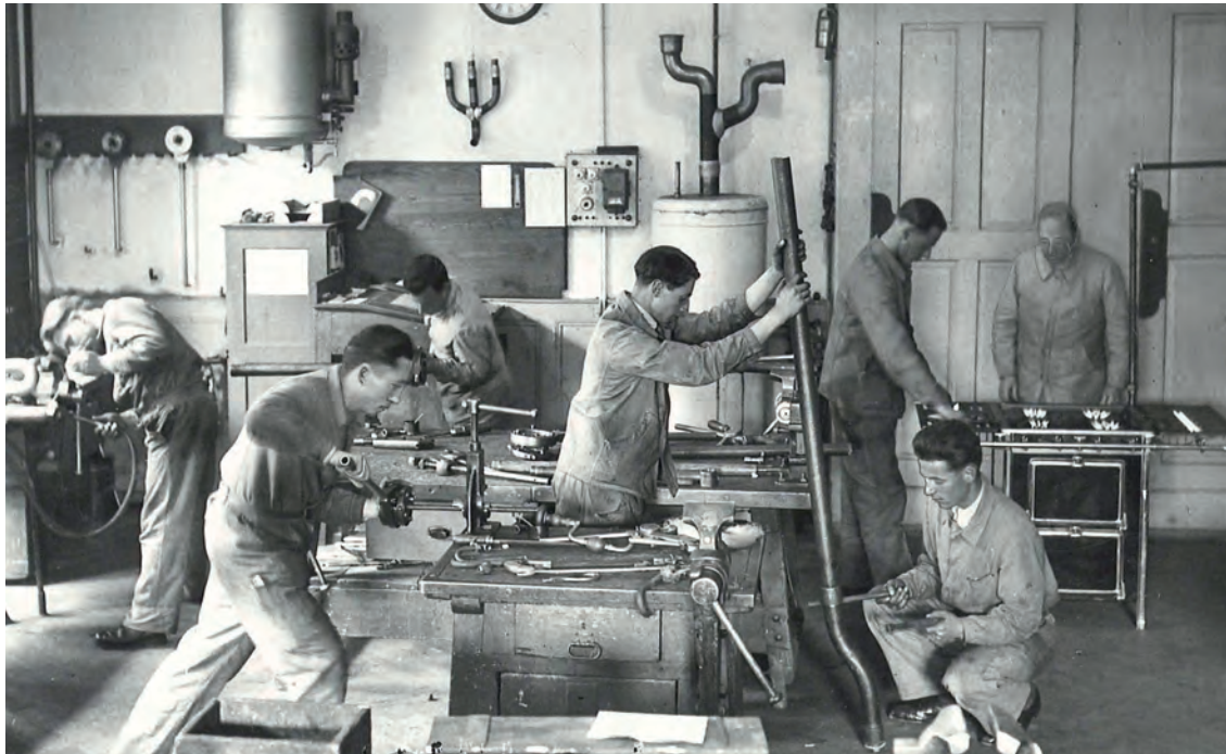
Schweizerische Fachschule für Sanitärinstallateure 1937. Praktische Übungen – Vorbereitung auf die Meisterprüfung.
