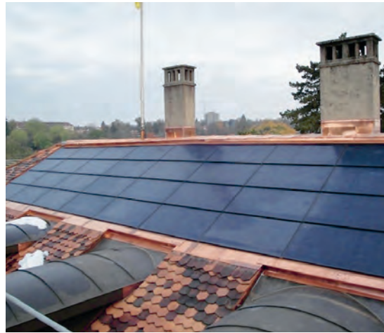
Westteil der Solaranlage auf dem LWB-Dach.
