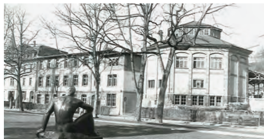
Filiale 1: Aarstrasse 96, Sanitär- und Spenglerabteilung. Eröffnet 1969, umgebaut und erweitert bis 1973.
