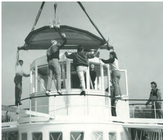
Aufsetzen des Falzdachs auf das Steuerhaus des restaurierten Dampfschiffs «Blümlisalp» im Oktober 1991. Ausgeführt durch die Spengler- und die Innenausbauabteilung.
