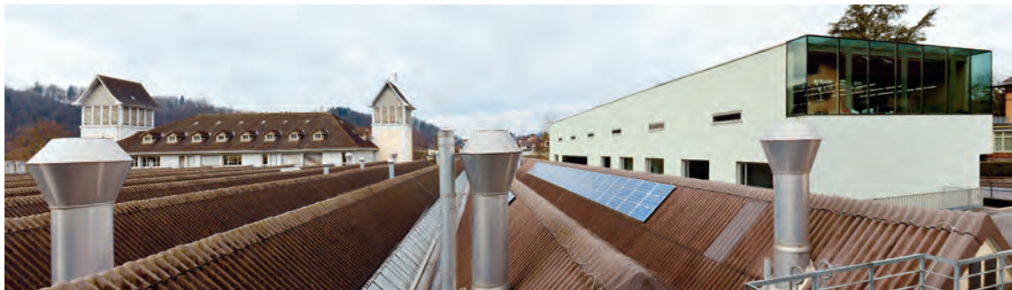
Die ehemaligen Spinnereifabrikhallen und der Kopfbau in der Felsenau. Standort für die Innenausbau-, die Metallbau- und die Spenglerabteilung.
