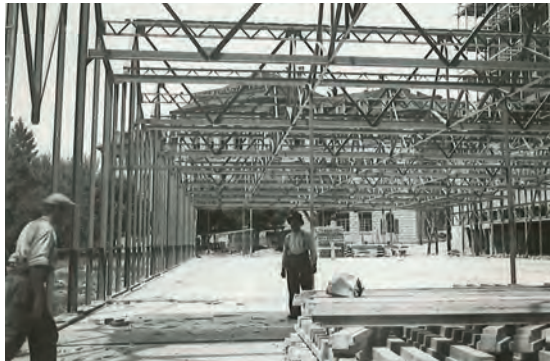
Das Shed im Rohbau. Im April 1938.
