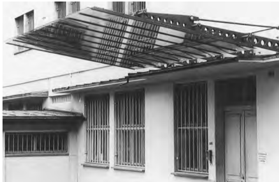
Vordach im Innenhof der Strafanstalt Thorberg 1991. Hergestellt von der Metallbauerabteilung.
