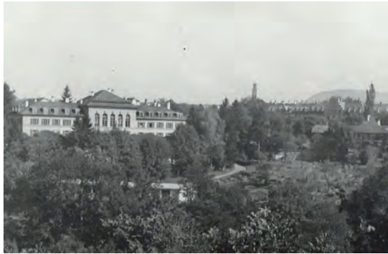
Die Situation vor dem Bau. Das Blindenheim und die alte Fahnenfabrik 1934.
