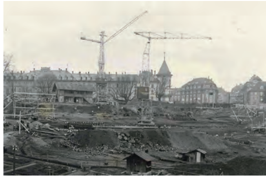
Während des Baus. Im Frühjahr 1937.
